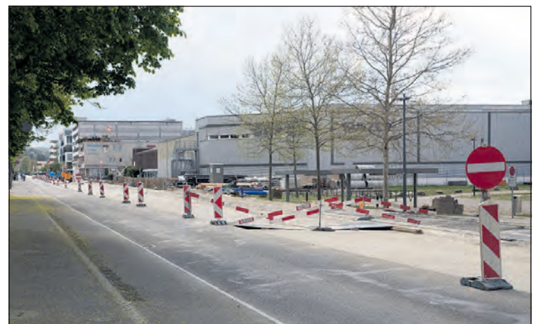
Beim Hegenheimermattweg laufen die Arbeiten auf dem Abschnitt Kreuzstrasse-Im Brühl.
