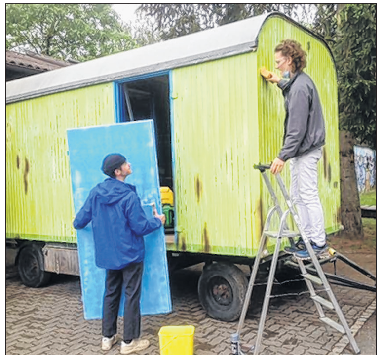
Aus Alt mach Neu: Die Fassade des Spielwagens wird einer Renovation unterzogen.
