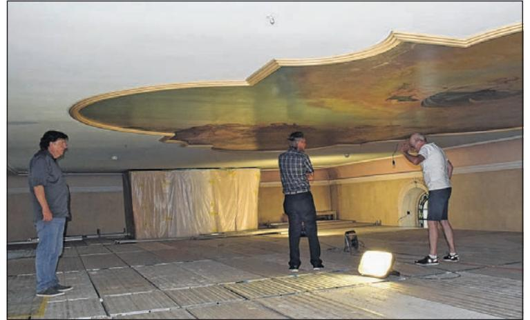
Unter der Decke des Kirchenschiffs wurde ein Gerüstboden konstruiert. Dadurch kann beispielsweise das Deckengemälde gereinigt werden.
