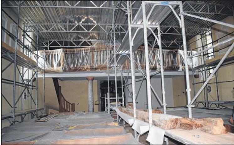
Im Inneren wurde ebenfalls ein Gerüst gestellt, sodass die Wände gereinigt und Elektroinstallationen getätigt werden können.
