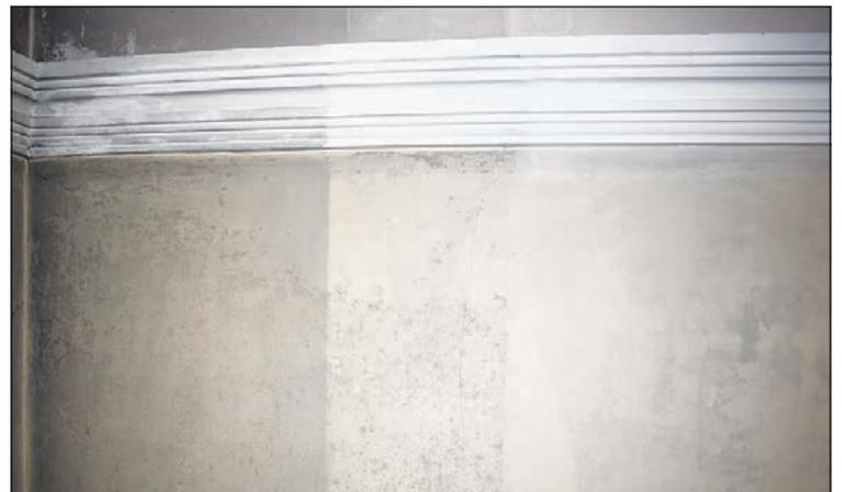
Die Wände wurden stufenweise gereinigt. Die Streifen zeigen: Originalzustand – nach Trockenreinigung – nach Feuchtreinigung (von links).
