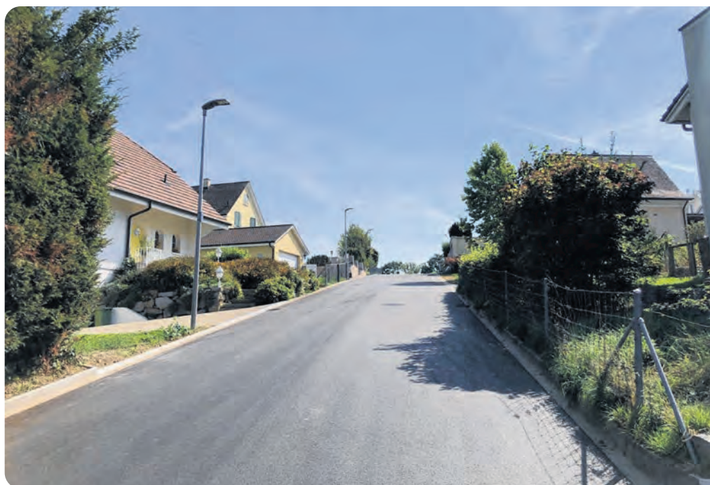
Die Bauarbeiten am Engehollenweg sind abgeschlossen. Der Gemeinderat hat die Kreditabrechnungen genehmigt.
