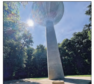
Anlass auf der Waldbühne beim Wasserturm.
