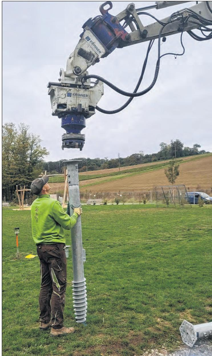
Am 1. Oktober wurden auf der Plumpi die Schraubfundamente für den neuen Turm von einer Spezialfirma gesetzt. Ganz so schwergewichtig werden die Arbeiten bei der Mitmachbaustelle am 6. November nicht werden, dafür sind aber auch alle grossen und kleinen Bauarbeitenden eingeladen.
