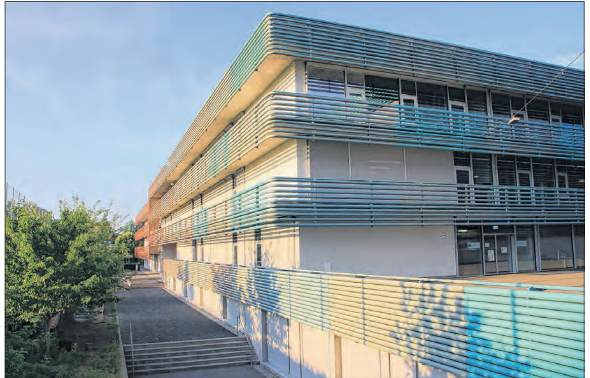
Seit letztem August verfügt das Schulhaus Gartenhof über Sonnenstoren, die ihre Funktion erfüllen. Das war davor während acht Jahren nicht der Fall gewesen.
