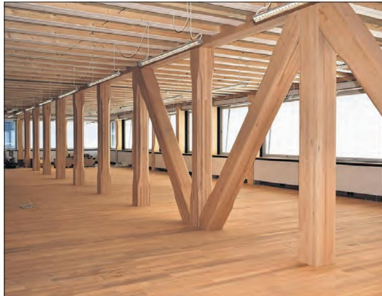
Die Stockwerke des Baus enthalten mehrere Reihen mit Holzstützen. Die diagonalen Balken dienen zur Erdbebenaussteifung.
