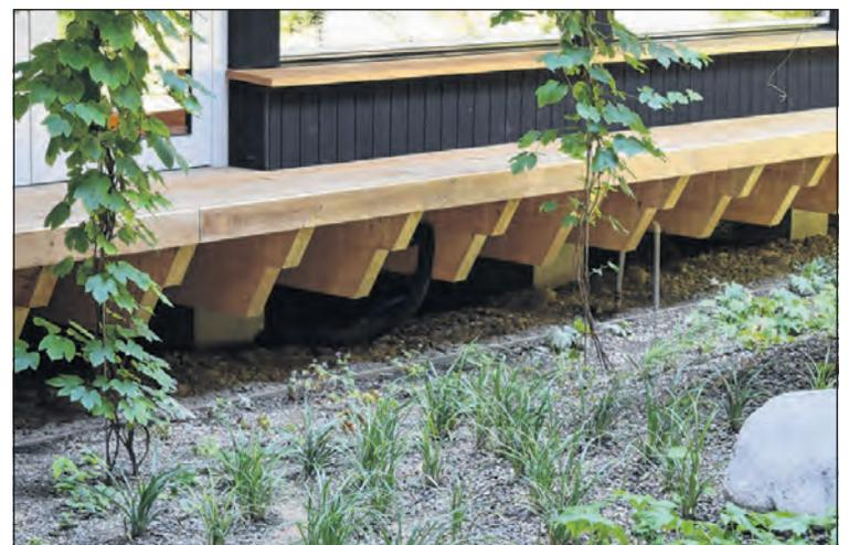
Die Bodenplatte des Gebäudes berührt die Erde nicht, sondern steht auf Zementfüssen. So konnte auch sie aus Holz gefertigt werden.
